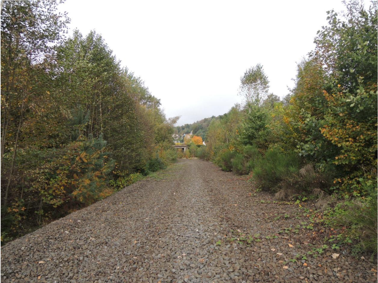
Aktuelle Situation im Areal, Blick auf die rückgebauten Bahnanlagen mit Gleisschotter
